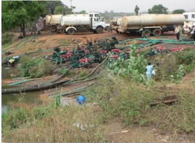
Bild: Aus dem Bericht „SUDAN INFRASTRUCTURE SERVICES PROJECT (SISP)“, von USAID, Nov. 2008
